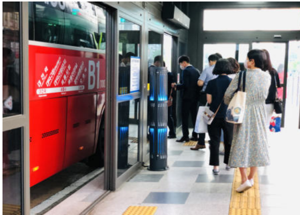
그림 8. 준실외공간인 버스정류장에 설치된 미세먼지 저감장치와 공기질 정보 수집장치 활용 스마트 제어 사례 - 세종시 BRT정류장
